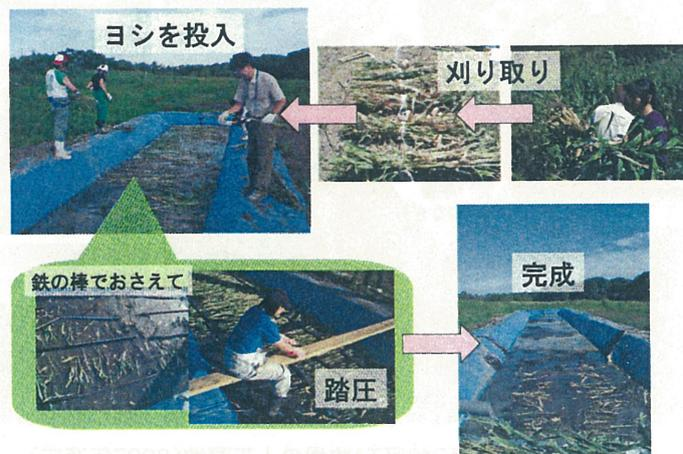
図7 稗敷設法(簡易法)の概要
